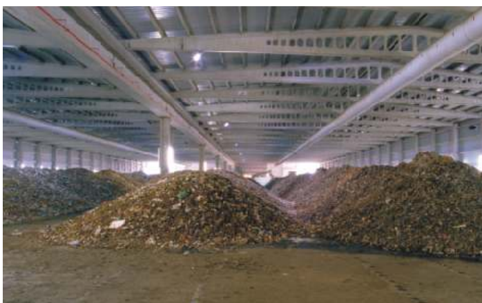
Nave de fermentación aerobia
